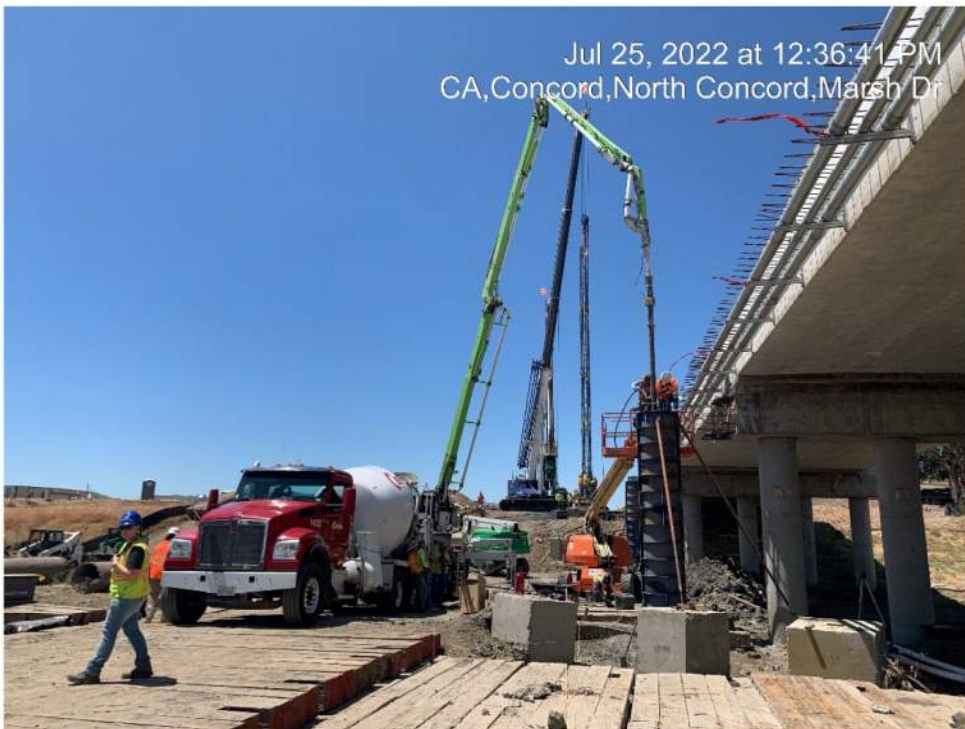
Figure 4 – Column 3 (E) Rebar, Form and Pour
